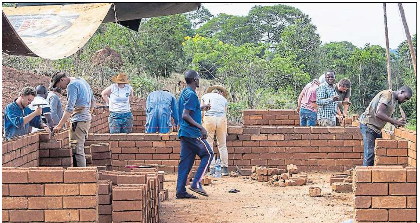
Gemeinsam ziehen einheimische Arbeiter und Studierende der Jade Hochschule die Wände hoch.
